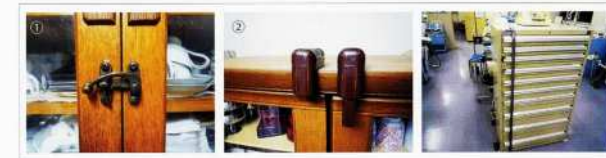
図5 開き戸・引き出しの固定方法の例
